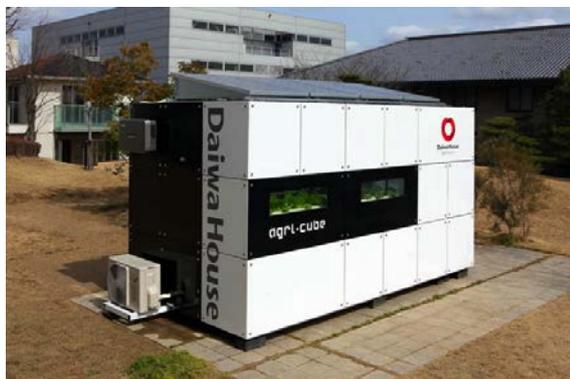
工場を組み立て、現地にはクレーンで設置しますので給排水の工事をすればすぐに野菜を育てることができます。エアコン、換気システム、照明なども備え、入り口にはエアカーテンが組み込まれていて昆虫などが入り込むことを防いでいます。栽培室に入ると左右に棚が並んでいてこの棚の中の配管を肥料を含んだ水が循環していて野菜の水耕栽培を行います。棚ごとに水の循環量や照明の照射時間を設定できますので、種まきから収穫までそれぞれの生育段階で最適な条件で栽培を行うことができます。
